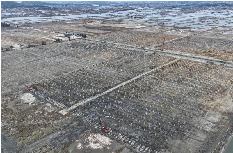
漳浦盐场项目施工现场
