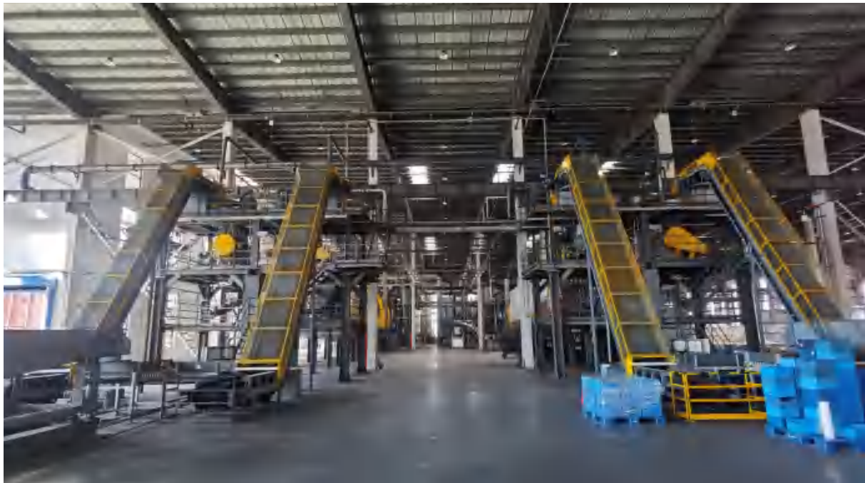
国轩高科废旧电芯回收破碎产线
