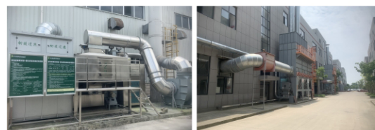
废气处理设备更新活性炭+催化燃烧系统提高废气处理效率
