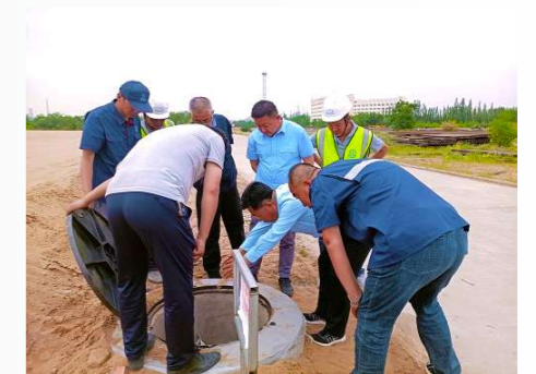
公司领导检查宁东铁路电气化改造项目基础设施
