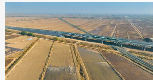
宁东铁路崇胡道口“平改立”立交桥正式通车
