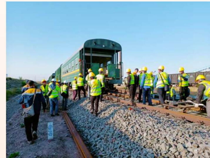
无缝线路换铺
