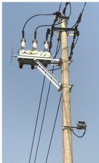
图 2：智能柱上开关安装效果及示意图
