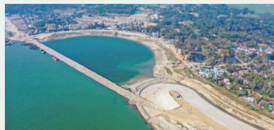
电建港航公司实施的世界最大河道整治项目——孟加拉帕德玛大桥河道整治项目全面完工，大幅减少水患的发生
