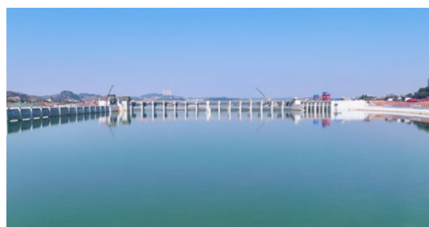
湖南犬木塘水库枢纽首台机组发电
