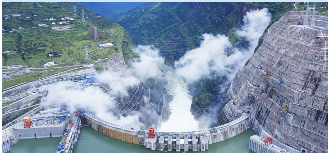
12月20日，公司勘测设计承建的金沙江白鹤滩水电站入选“全球十大工程成就”，代表了当今世界水电技术发展的最高水平
