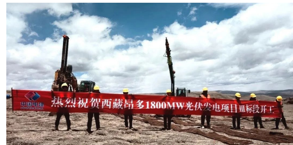
芒康昂多 1800 兆瓦光伏发电项目开工建设
