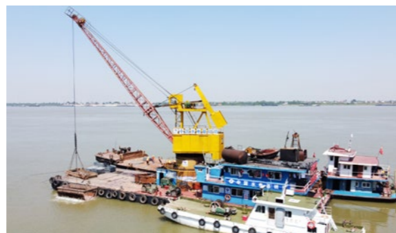
长江干流崩岸赛克格宾工艺施工，保护长江岸线
