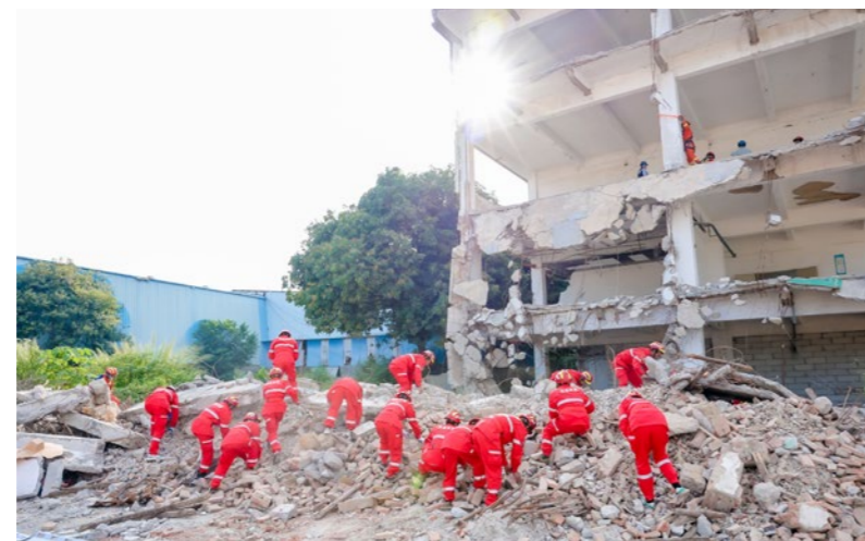
电建铁路公司参与“2023 年深圳房屋安全突发事件应急演练”
