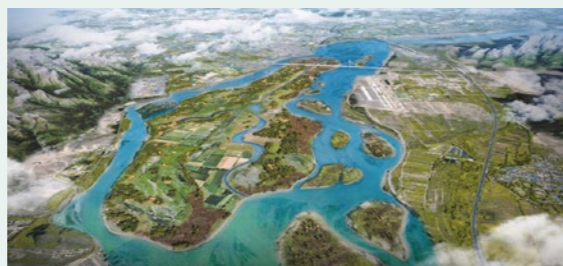
水电基础局承建的拉萨河谷（堆龙以西）生态保护修复试点工程采取采砂降滩、护滩固州的方式，实现以水治沙、防沙止漠
