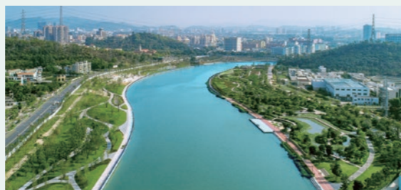
深圳茅洲河治理工程采用流域统筹、系统治理，使河水水质得到彻底改善，为城市高密度建成区开展水环境综合治理提供优秀范例
