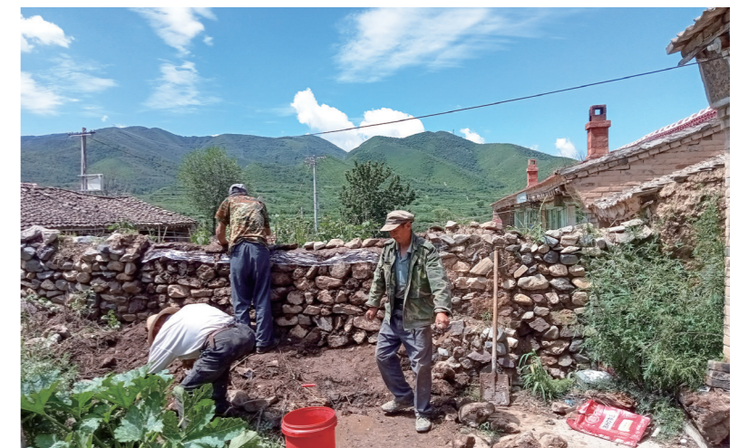
驻村工作队带领群众修复被雨水浸泡坍塌的围墙
