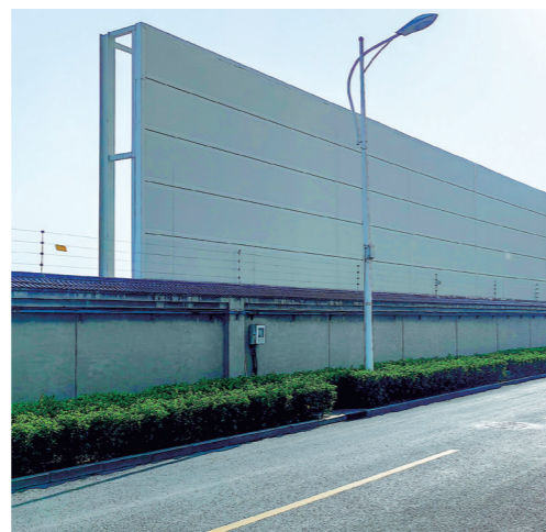
厂区隔音屏障
