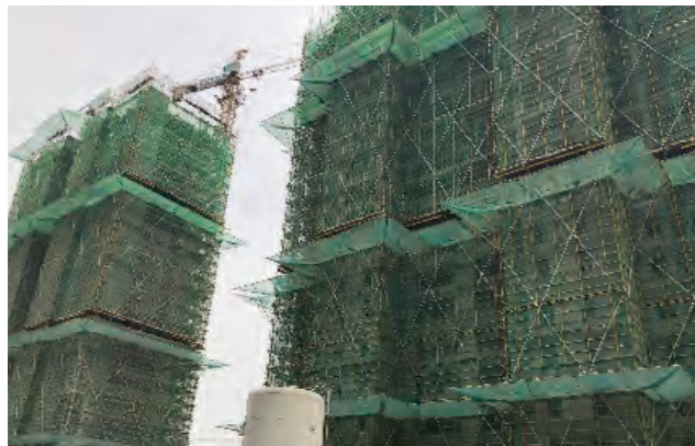
铝膜 1.0 版施工现场
