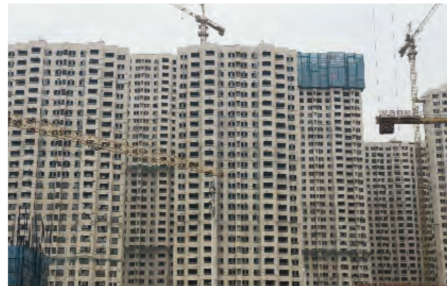
铝膜 2.0 版施工现场
