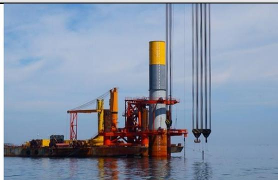
公司生产的桩基是海上风电设备的支撑基础，其上端与风电塔筒连接，下端深入数十米深的海床地基中，用以支撑和固定海上的风电塔筒以及风电机组，其对海底地质和水文条件要求较高。
