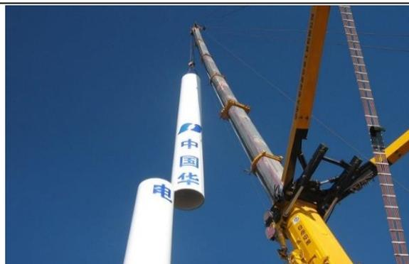
公司生产的风电塔筒是风电设备的重要组成部分，作为风电机组和基础环（或桩基、导管架）间的连接构件，传递上部数百吨重的风电机组重量，也是实现风电机组维护、输变电等功能所需的重要构件。其内部有爬梯、电缆梯、平台等内件结构，以供风电机组的运营及维护使用。
