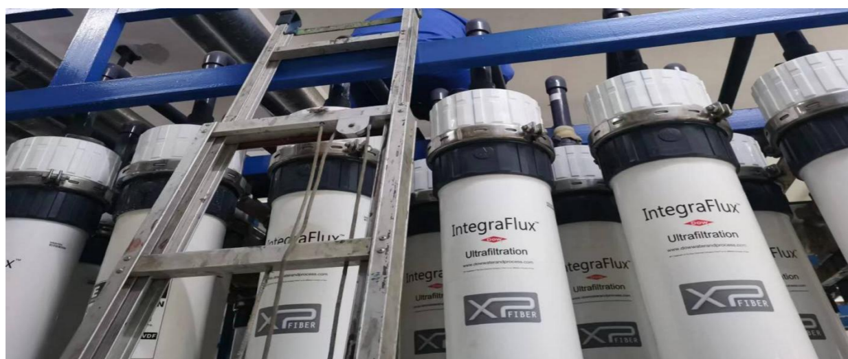
二期中水改造项目现场
