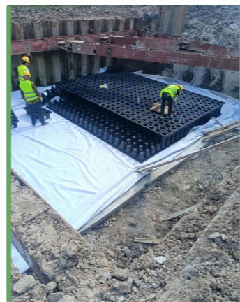
H2 地块海绵城市建设现场
