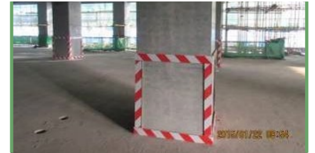
模板废料制作柱子护角
