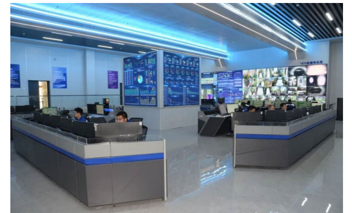
冷轧总厂冷轧智能集控中心
