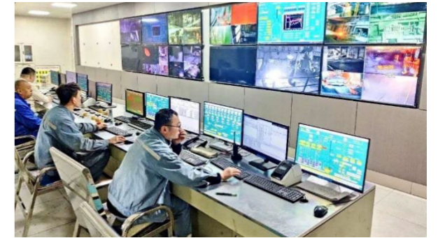
炼钢厂六号转炉主控室
