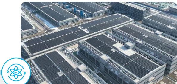
腾讯天津高新云数据中心 10.54 兆瓦新能源微电网项目
