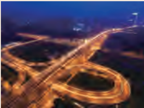
已建成的成都二环路东段改造工程夜景
