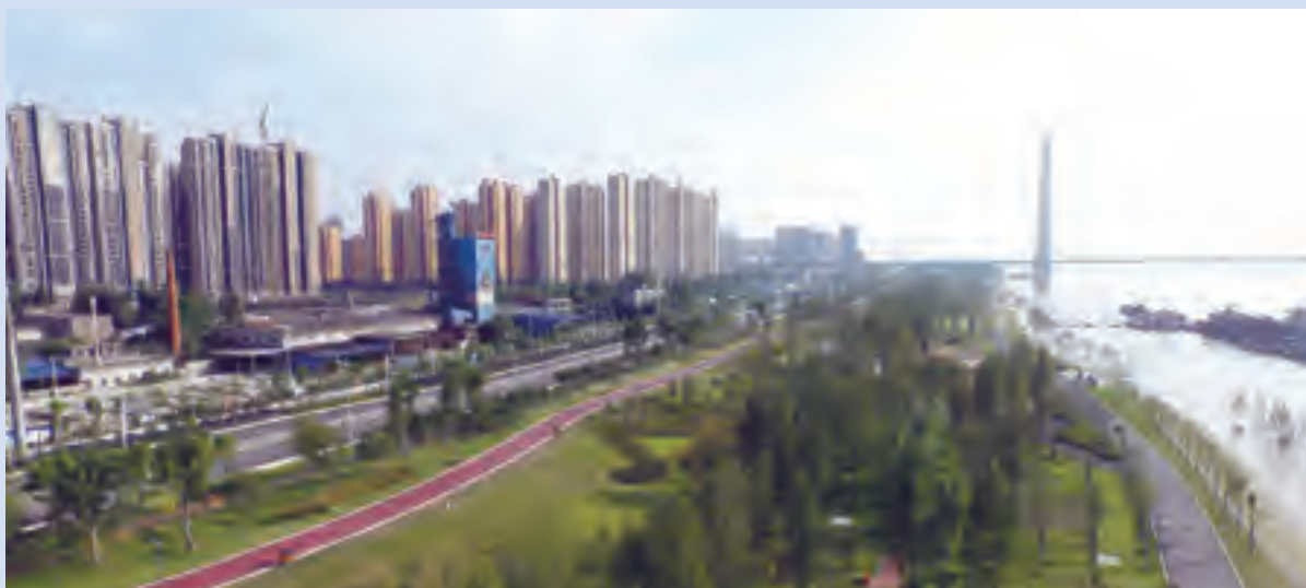
武汉市武青堤江滩综合改造工程
