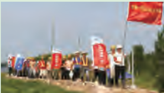
通顺河固堤抢险
