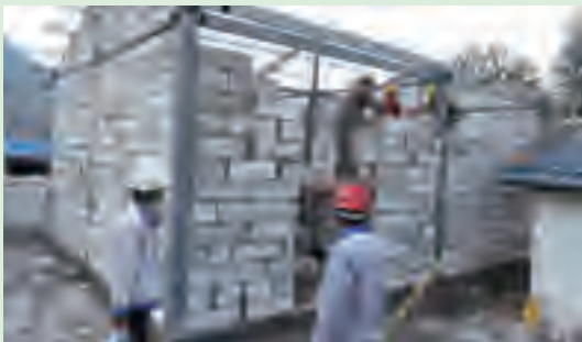
正在施工中的凉山州扶贫安置房
