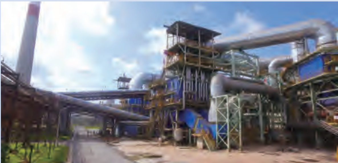
宝钢湛江钢铁基地烧结余热发电工程
