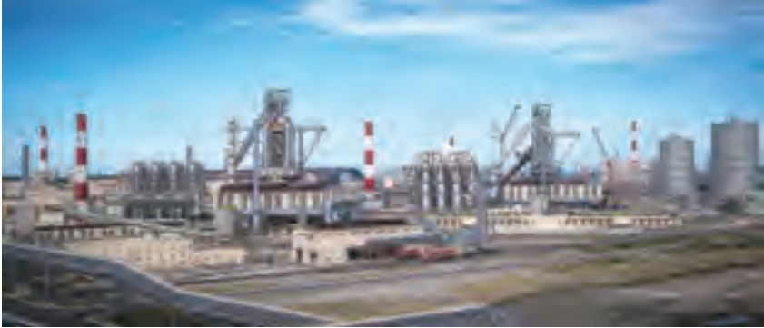
台塑河静钢铁 1 号 2 号高炉
