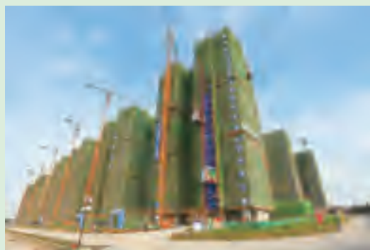
湖北襄阳樊城衡庄保障性住房项目
