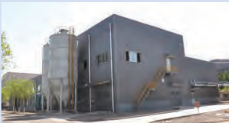
天津钢铁集团有限公司生产废水系统深化改造工程
