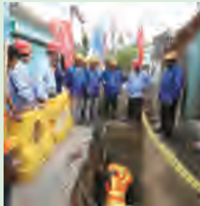
地下管网供水项目施工现场
