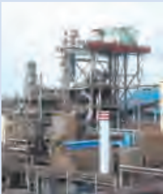
马钢干熄焦国家示范工程
