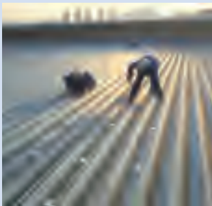
宝钢股份金太阳光伏发电示范工程
