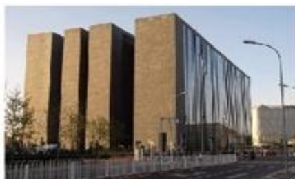
奥运数据中心
