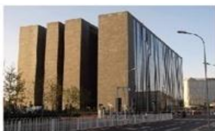
奥运数据中心
