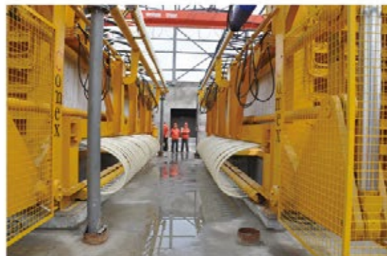
焦家金矿尾矿脱水再利用
