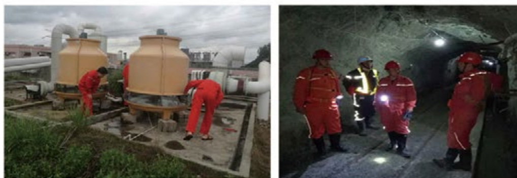
安全隐患排查
