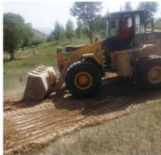
公司修缮驻地道路
