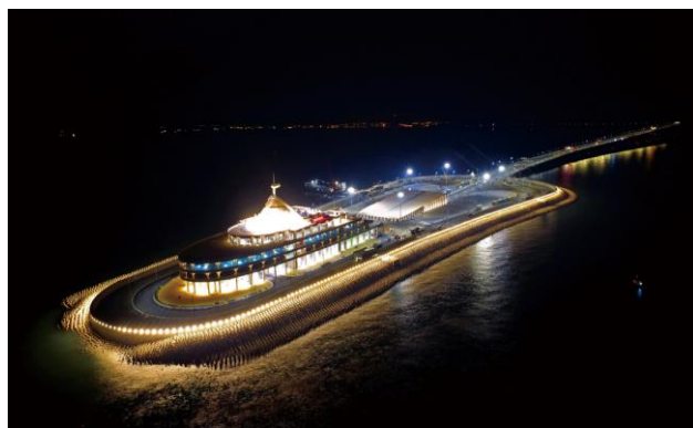
港珠澳大桥东人工岛亮灯
