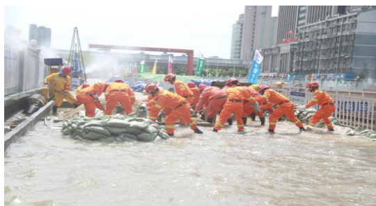
中交一公局集团长沙地铁项目举行“盾构施工突涌”与“基坑防汛应急演练”
