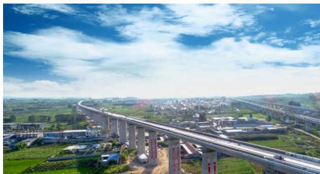
鲁南高铁设置污水集中处理设施
