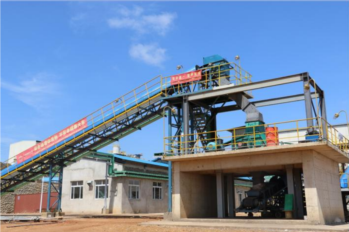
氢氧化钴项目磨矿工段
