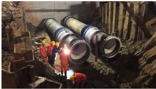
洋里污水处理厂提标改造夜间施工
