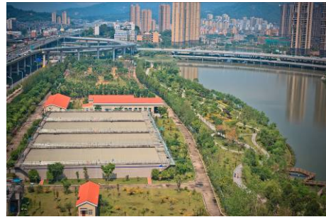
旗下浮村污水处理厂全貌
