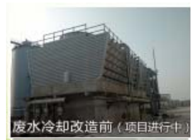
▲废水冷却塔改造项目
