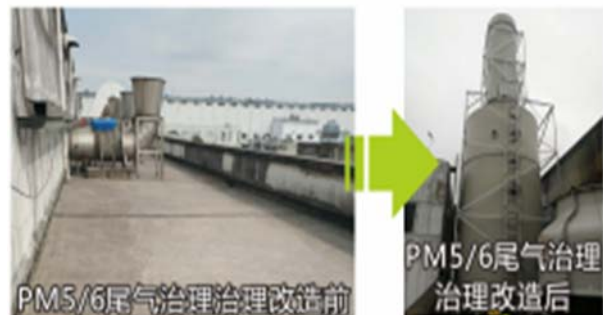
▲PM5/6车间气罩排风除臭项目
