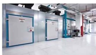
EMC实验室（外部）
