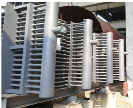
MGGH 是通过水作为热媒介来传递热量实现热烟气加热冷烟气的装置，布置在除尘器前的烟气冷却器将循环水温度提高，烟气自身温度由约 130℃ 降到约 90℃ 后进入除尘器；布置在烟囱前烟气加热器利用已加热循环水将烟气温度从约 50℃ 提高 80℃ 以上，加热后的烟气进入烟囱排放，循环水在烟气加热器中温度降低再循环进入除尘器前的烟气冷却器加热。
