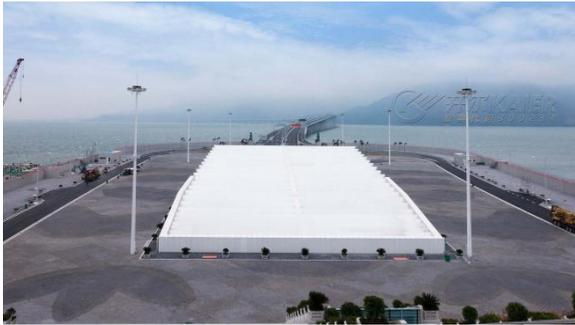
人工岛隧道入口减光罩——侧墙装饰
