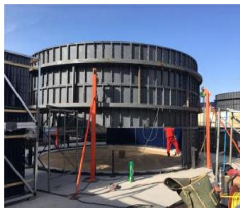
为了解决原来用耐火砖、玻璃钢、防酸腐蚀涂料、钛合金等防腐材料的缺点，如安装困难、重量大、工期长、成本高等，公司自主创新采用焊接、胶粘、螺栓连接等工艺将单块珐琅板组装成整体，形成烟道。本品能有效解决脱硫脱硝改造给燃煤电厂烟道带来的积灰和腐蚀压力，能够节约电厂维护成本，获得较好经济效益。
