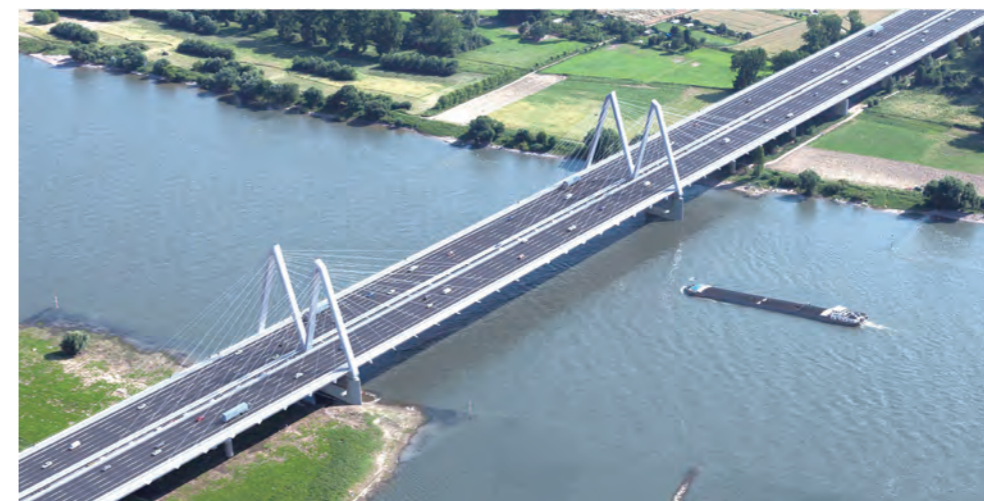
中铁山桥参建德国勒沃库森莱茵河大桥。
