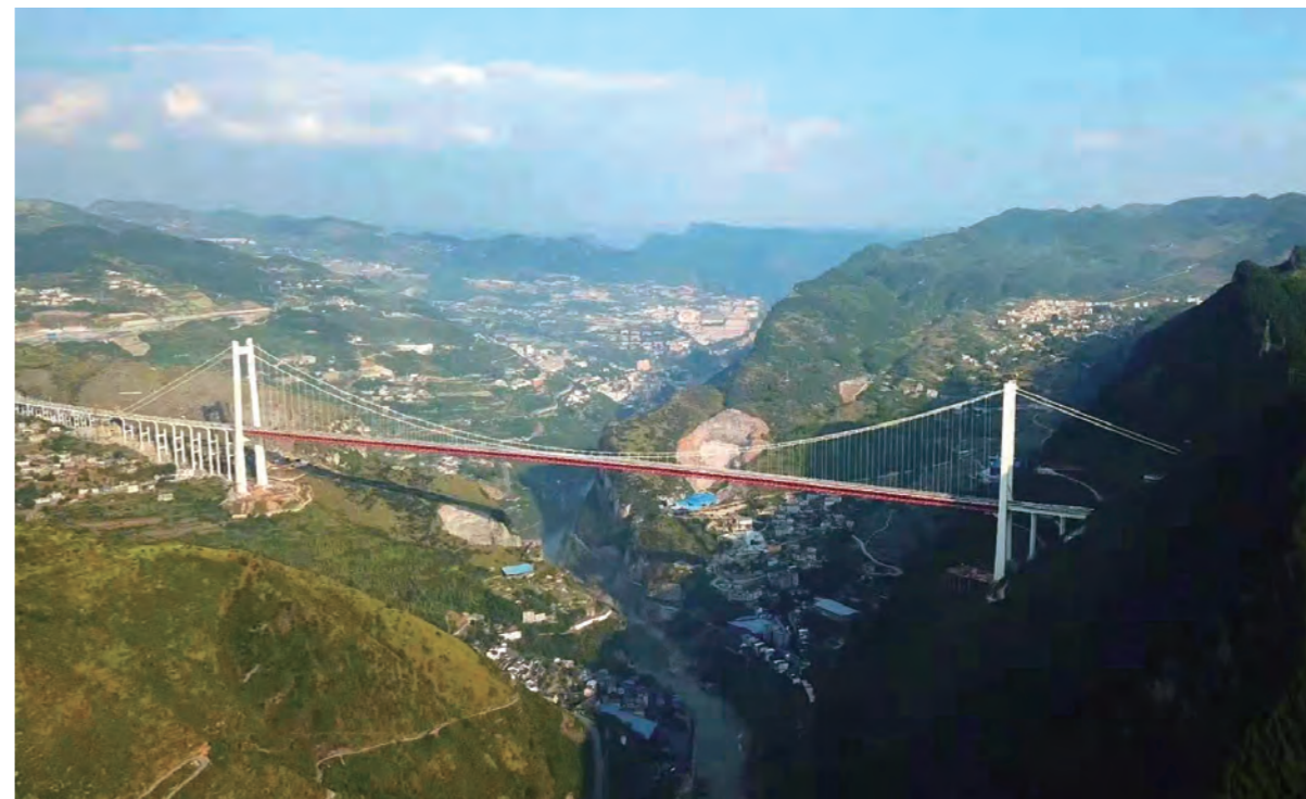
贵州赤水河大桥合龙。
