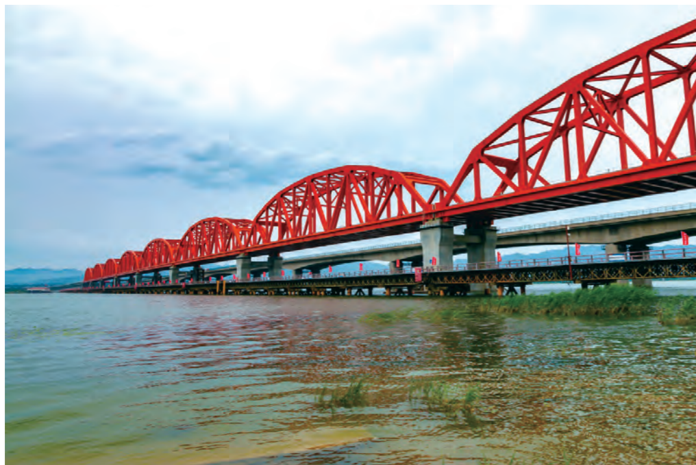
作为我国首条智能高铁——京张高铁的重要工程，公司参建官厅水库特大桥。
