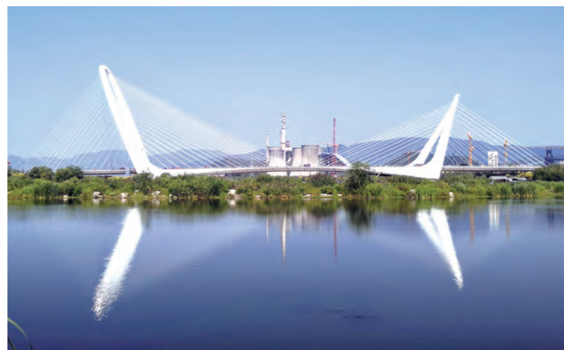
中铁宝桥参建的北京新首钢大桥贯通，作为长安街西延工程的最关键节点，该桥梁创造了北京地区跨径最大桥梁、中国最宽桥梁、设计结构世界首创等多项纪录。
