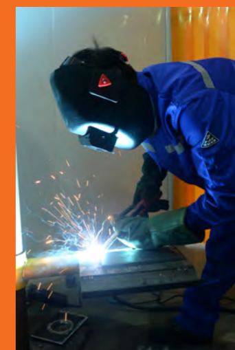
首届职业技能竞赛（电焊工）。
