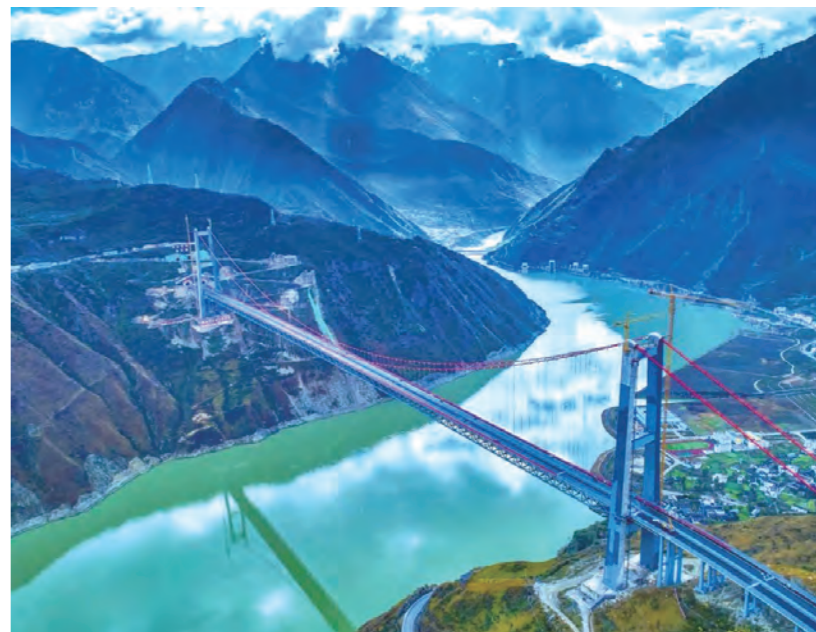
雅康高速泸定大渡河大桥建成通车。
