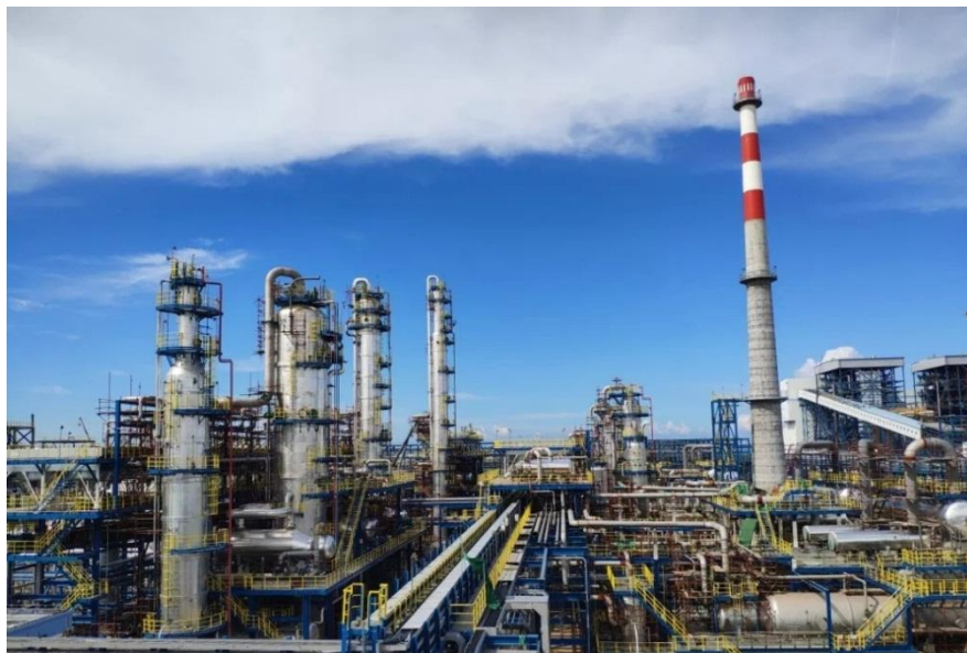
公司总承包的恒逸（文莱）硫磺回收装置
