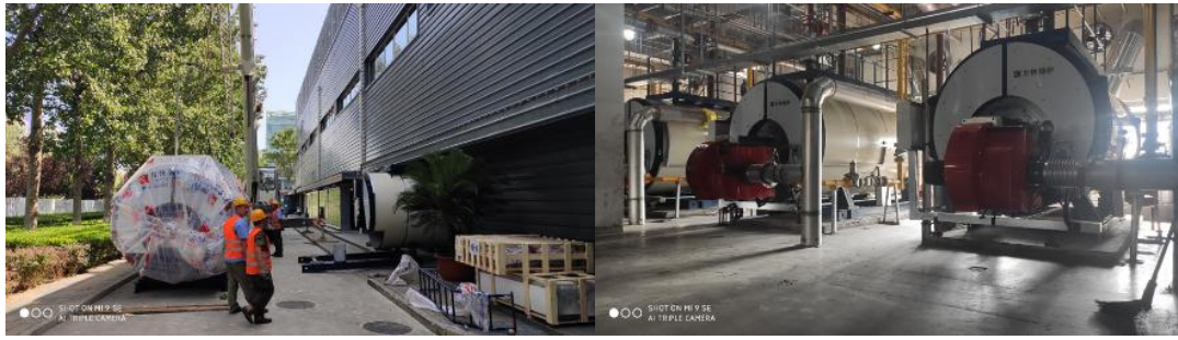
图注：对锅炉进行低氮改造
