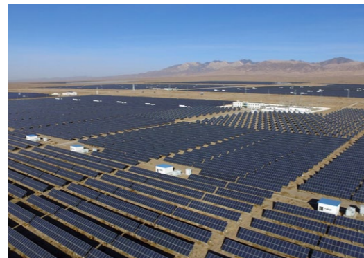
德令哈储能项目
