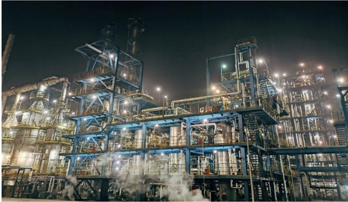
内蒙古聚实能源有限公司焦化升级改造生产清洁化工（FT 合成）项目
