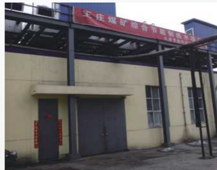
王庄矿空压机余热利用
