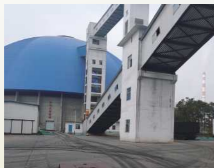
余吾煤业公司封闭式储煤场
