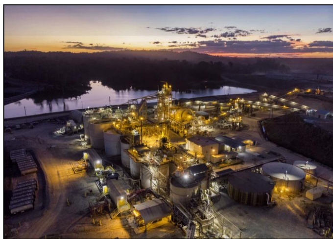
7,500 吨/日选厂现场图
