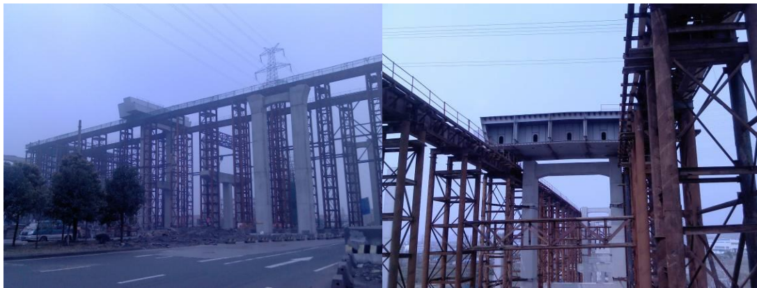
图例:使用“跨公路交通线超高层超宽变截面钢梁的顶推架设方法”的宁波市北环快速路工程 2 标项目施工现场
