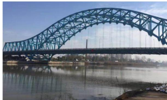
图例：泗阳成子河公路大桥 悬索桥结构
