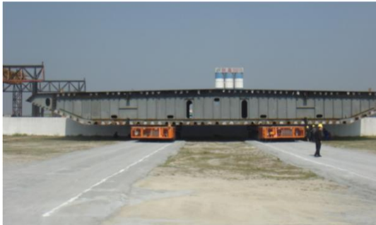
图例：珠江黄埔大桥 钢箱拱桥结构
