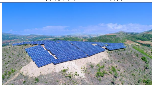
中国河南洛阳 25MW 项目
