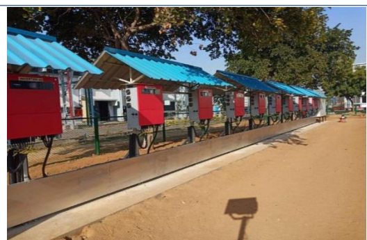
博世 4MW 项目
