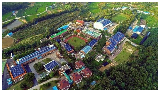
韩国 Andong500kW 项目
