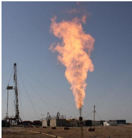
PRDS18 井试气现场照片
