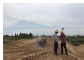
RTK 在道路施工放样中的应用
