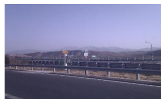
京承高速 边坡在线监测系统
