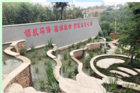
农村污水处理
