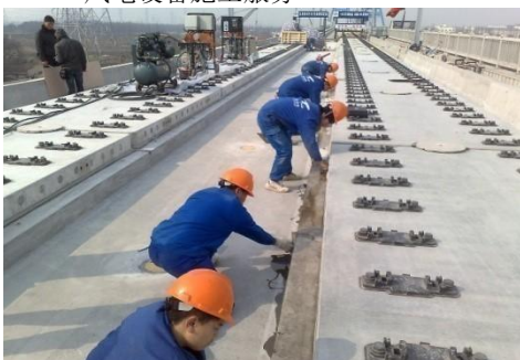
轨道建设工程施工服务
