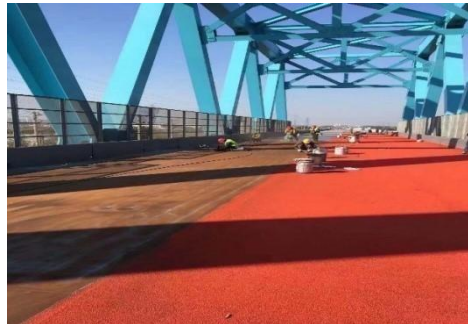
桥梁工程防水
