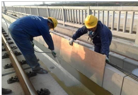
轨道建设防水
