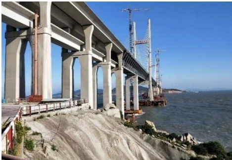
高铁混凝土桥梁防水
