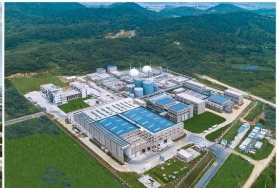
南京江北废弃物综合处置中心
