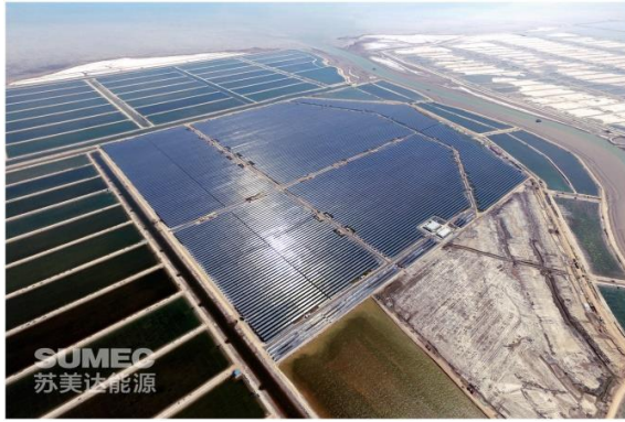
山东曙光光伏项目
