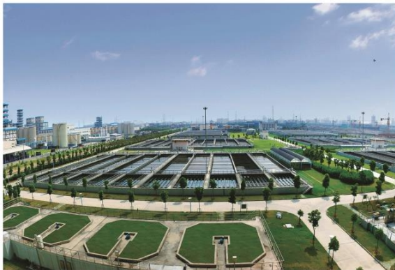
上海白龙港污水处理厂
