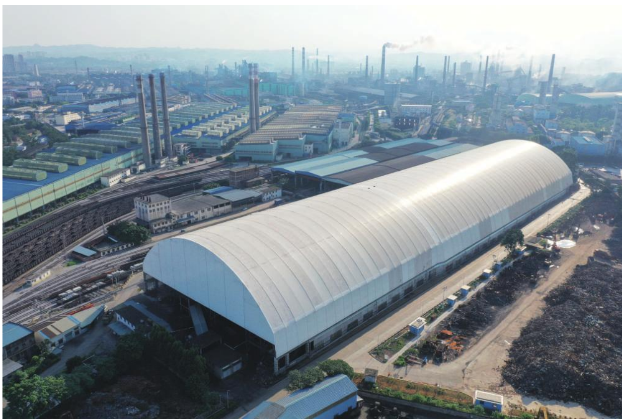
图为焦化厂五煤场防水抑尘大棚项目正式投用。
