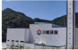
古叙垃圾发电项目
