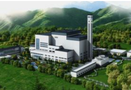
射洪垃圾发电项目
