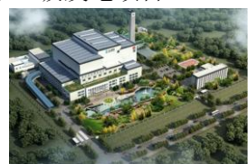
长垣垃圾发电项目（一期）
