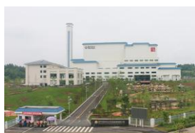
遂宁垃圾发电项目
