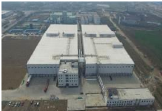
太古冷链物流（南京）冷库项目
