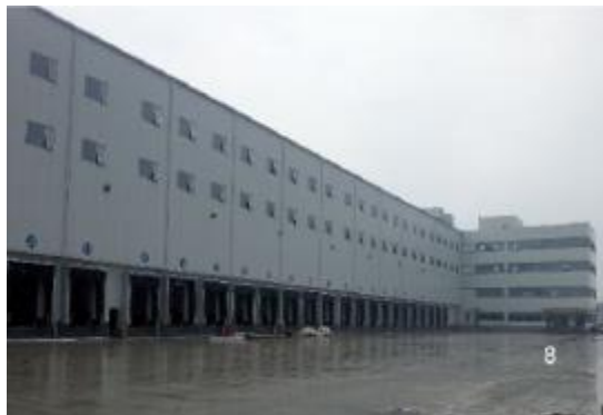
太古冷链物流（廊坊）冷库项目
