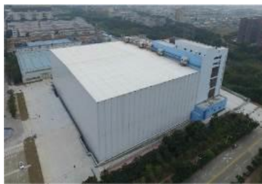
深圳华美冷链物流中心冷库项目
