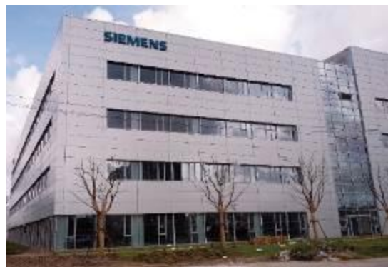
上海西门子厂房围护项目
