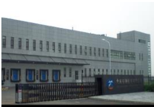
北京空港配餐楼冷库项目
