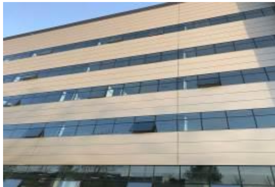
成都京东方光电技术测试中心外墙板项目
