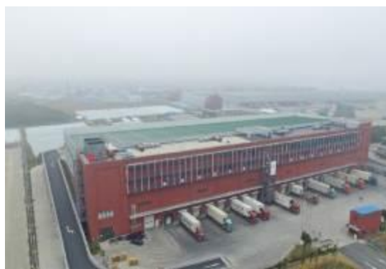
上海千隆物流有限公司冷库项目
