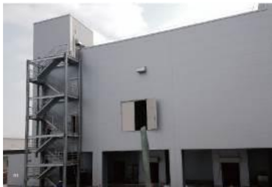
苏州长谷川厂房围护项目
