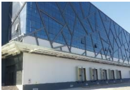
北京京津港国际物流有限公司立体冷库项目
