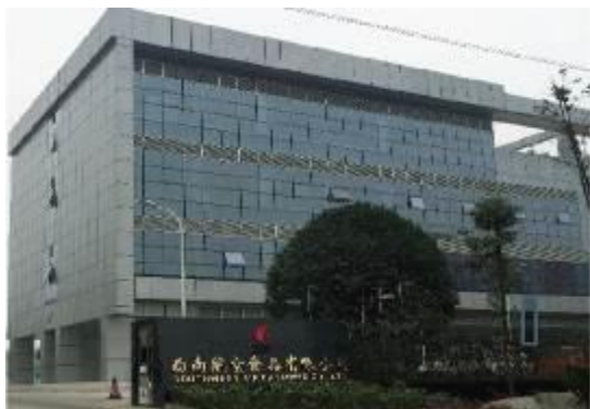
西南航空配餐楼冷库项目
