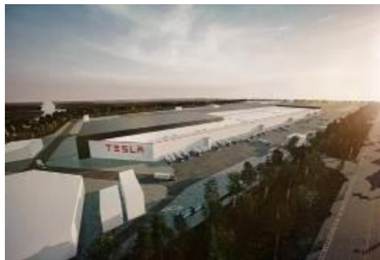
特斯拉上海超级工厂外墙板项目
