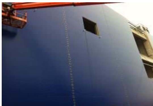
宜家家居（北京大兴）外墙板项目
