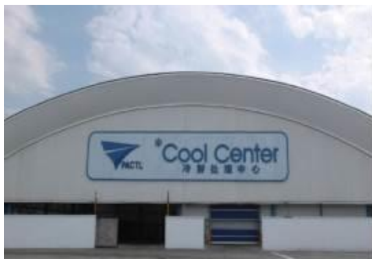
浦东机场冷鲜处理中心冷库项目
