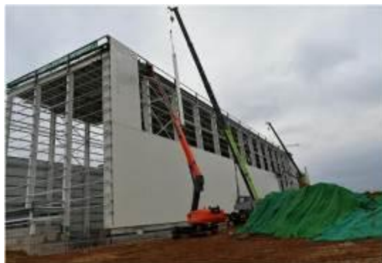
滇虹药业厂房外墙板项目
