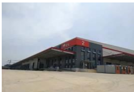
京东武汉新洲物流园项目
