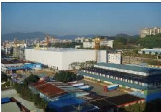
广州长运仓储冷库项目
