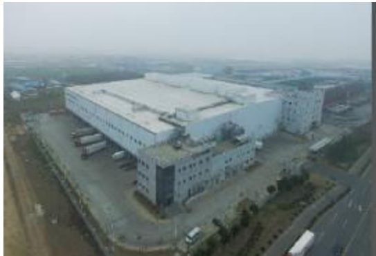
太古冷链物流（上海）冷库门项目
