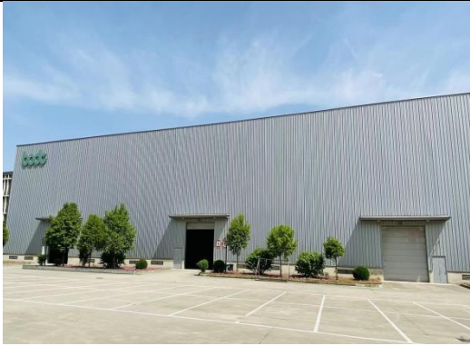
组合厂房外观
