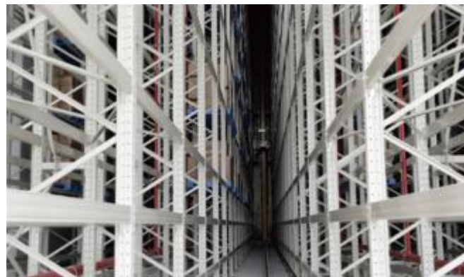
智能立体仓储系统
