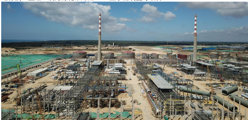
中委合资广东石化 2000 万吨/年重油加工工程主体装置项目
