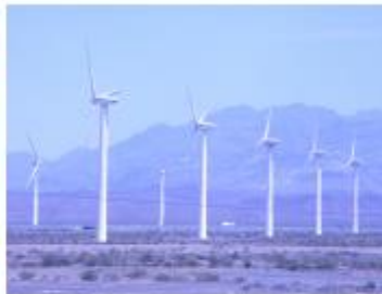
塔城发电(风力发电厂)
