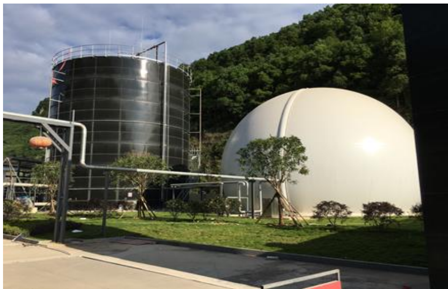
贵州铜仁污泥餐厨二合一处理工程
