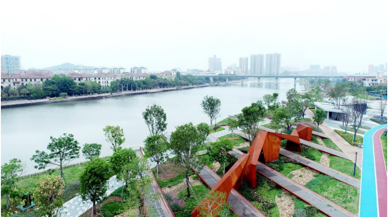
广东东莞市沙田镇西太隆河流域综合整治工程设计施工总承包
