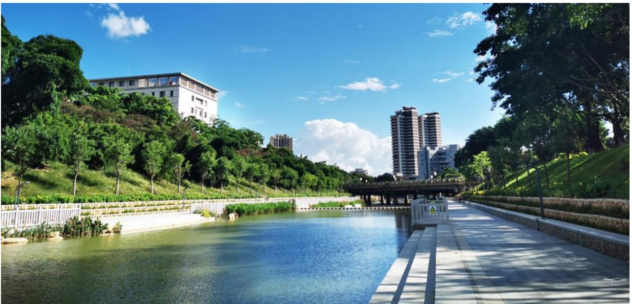
广东东莞石马河支流清溪水流域水环境综合治理
