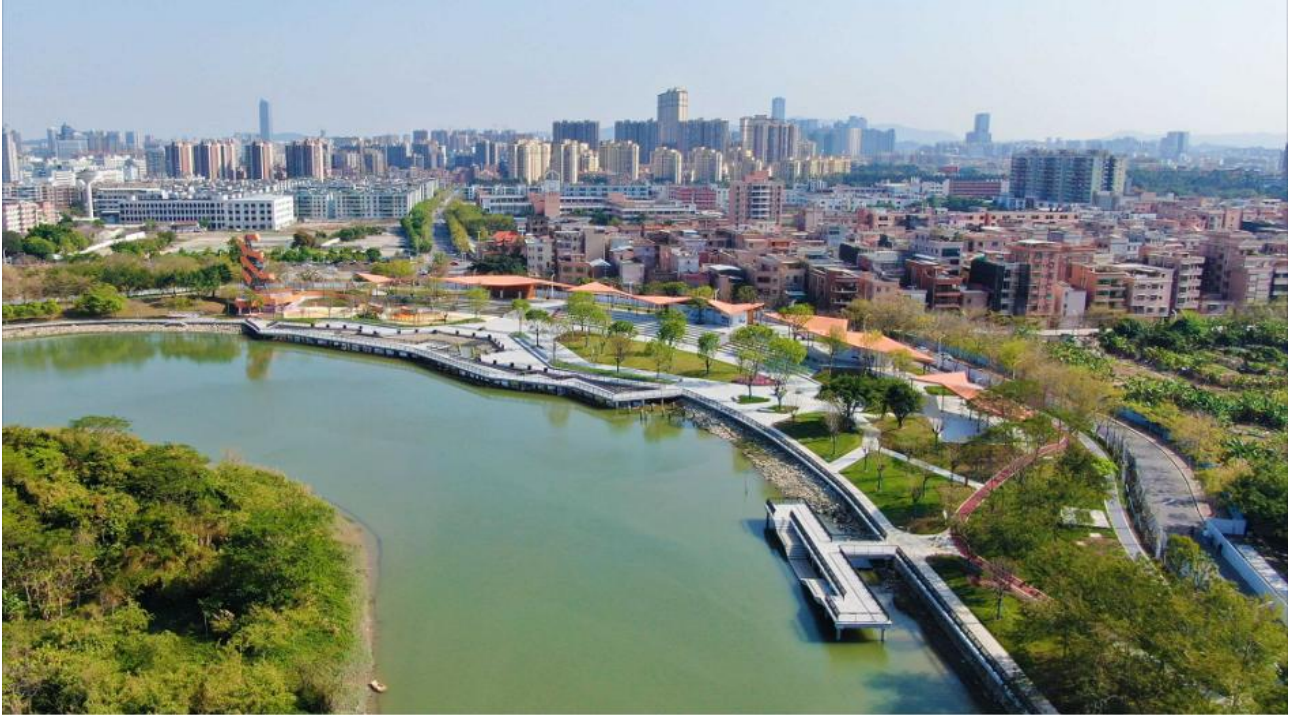
广东东莞“三江六岸”滨水岸线示范段项目一期工程(龙湾段)
