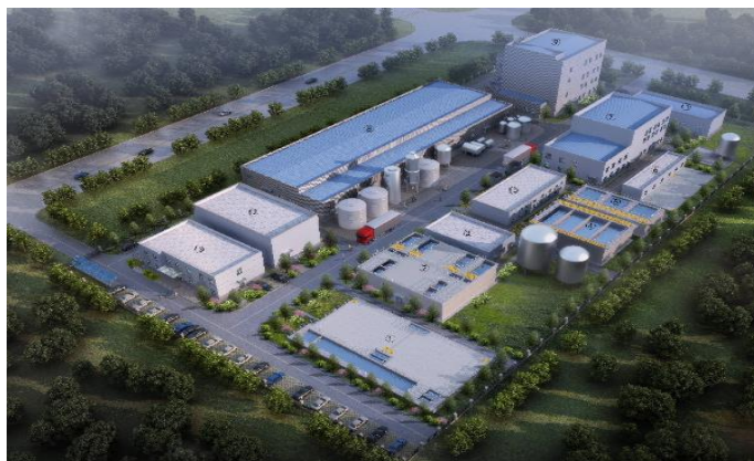
天津荣程联合钢铁集团有限公司工业废水回用零排放项目（设计处理水量为 13600m 3 /d）
