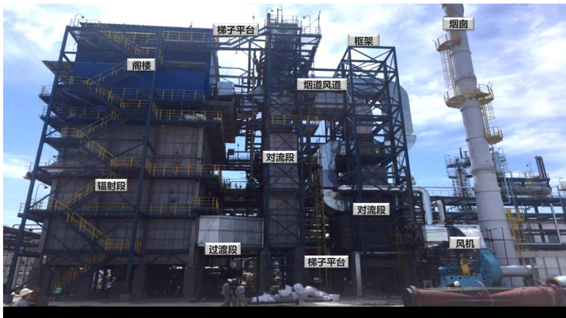
制氢转化炉安装示意图
