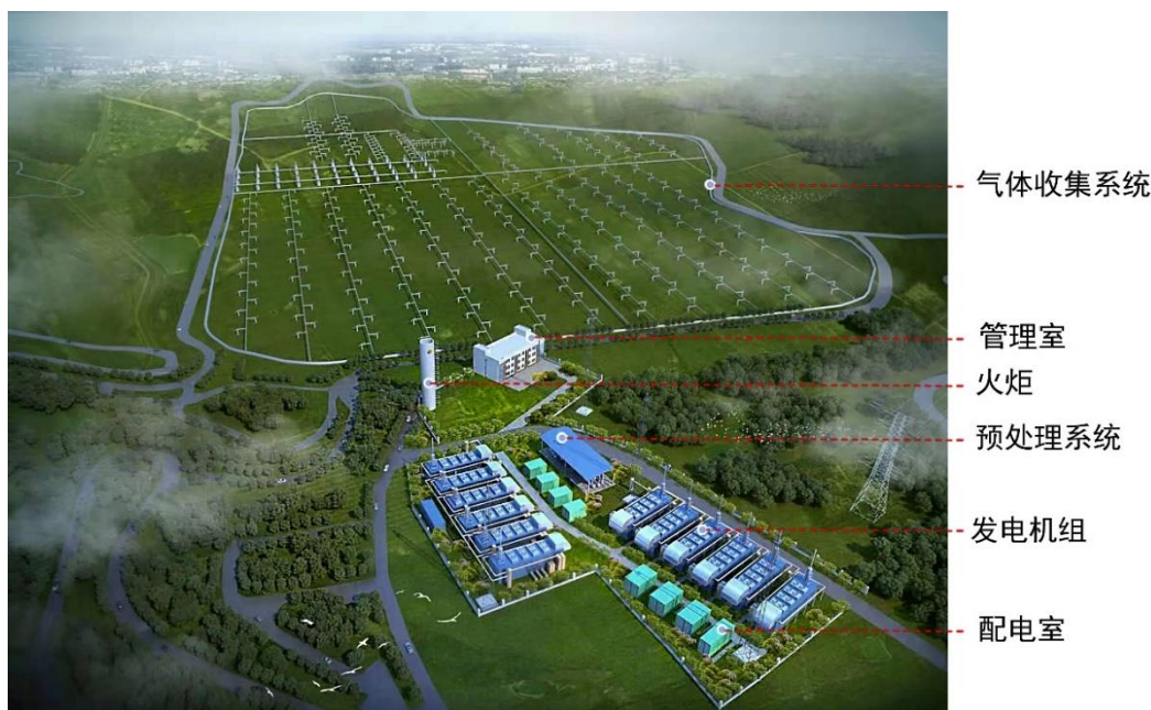
填埋气发电示意图
