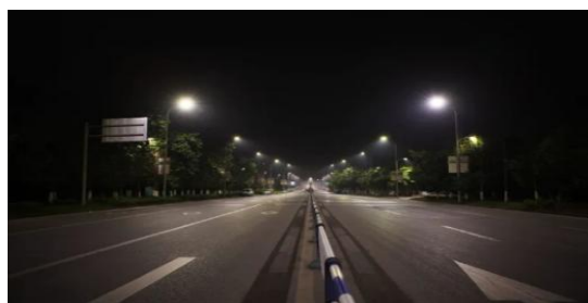
重庆市合川城区路灯项目
