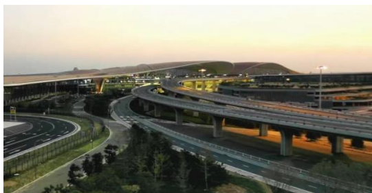
北京大兴国际机场路灯项目
